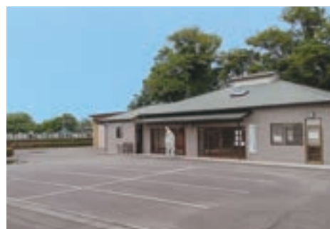
駐車場・管理棟
